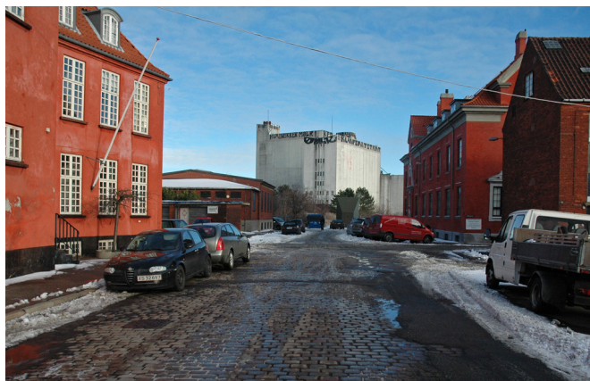
Århusgade med de bevaringsværdige siloer og bebyggelsesmiljøer
